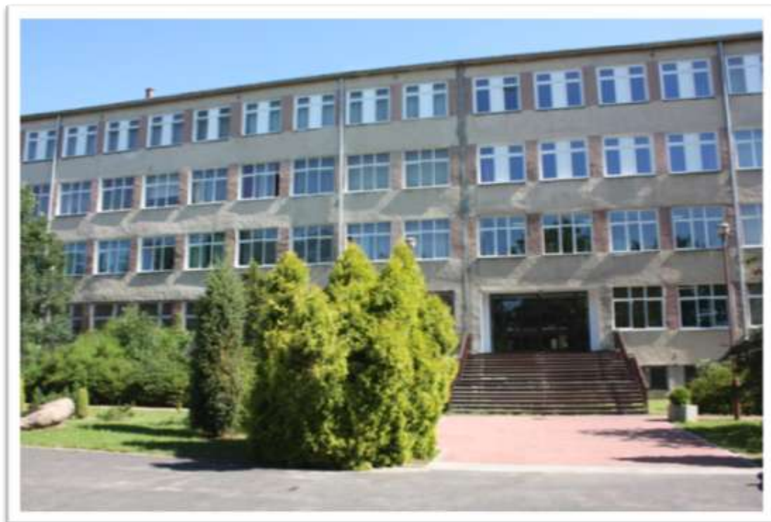
Blok szkolny Centrum Szkolenia Łączności i Informatyki.
