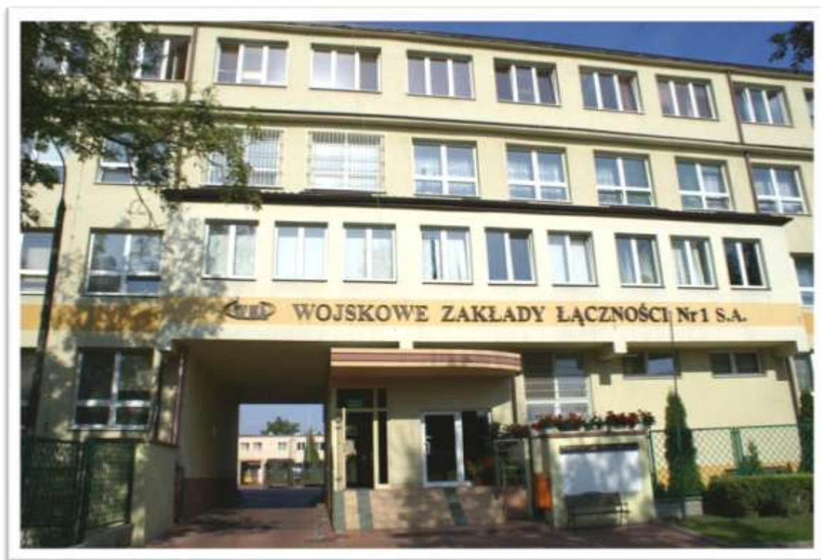
Siedziba Wojskowych Zakładów Łączności nr 1 S.A. w Zegrzu
