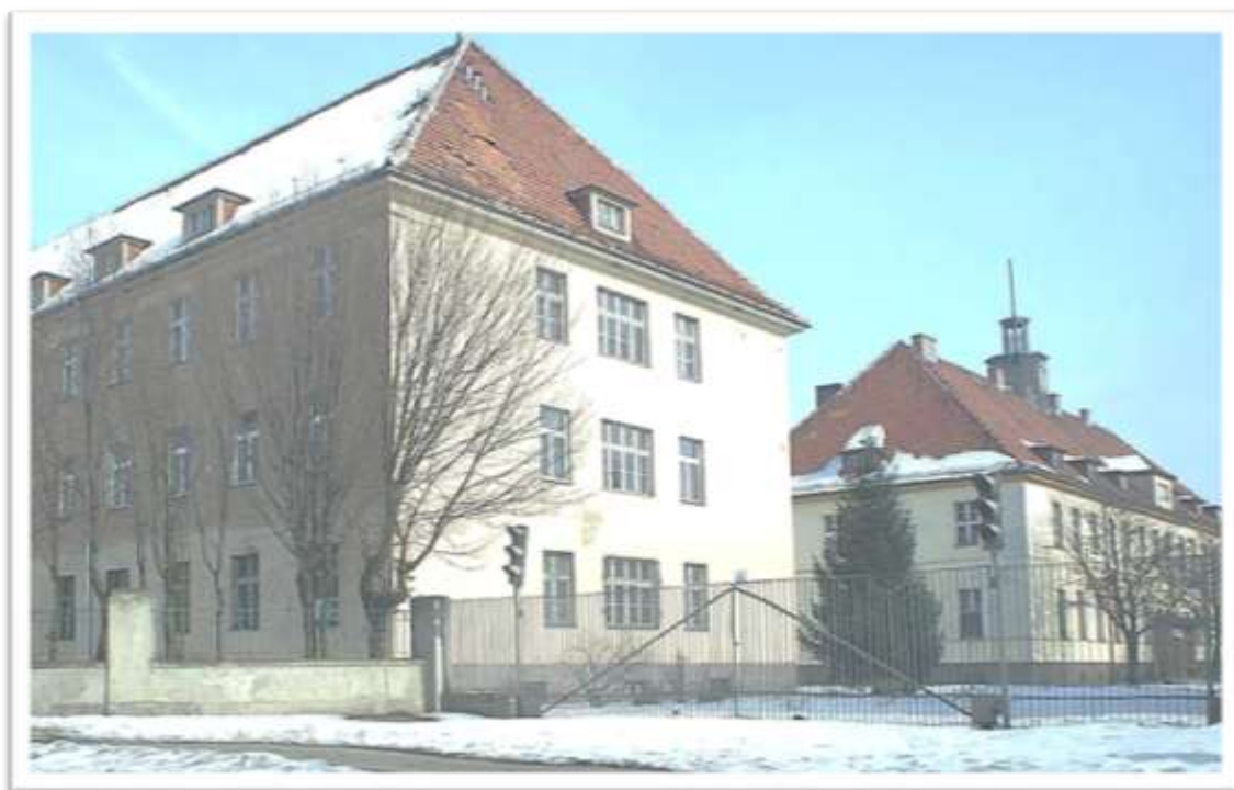
Budynki po Centrum Szkolenia Łączności.
