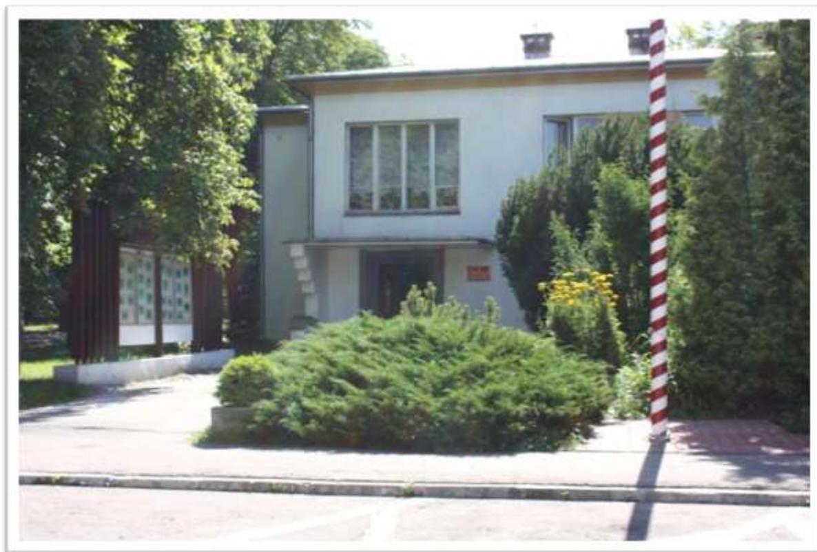
Budynek Komendy Centrum Szkolenia Łączności i Informatyki
