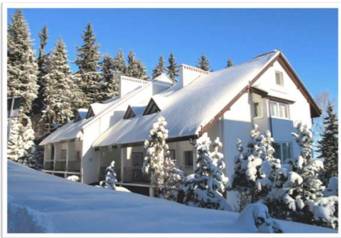
Świeradów Zdrój, 2010 r. Dom wczasowy „SŁOWACZKA”. Jeden z budynków Ośrodka Wypoczynkowego Wojskowych Zakładów Łączności nr 2 S.A
