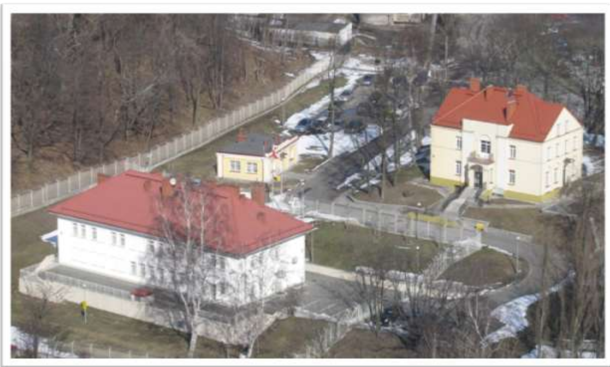
Gdynia Oksywie. Nowa siedziba Zespołu Informatyki Marynarki Wojennej
