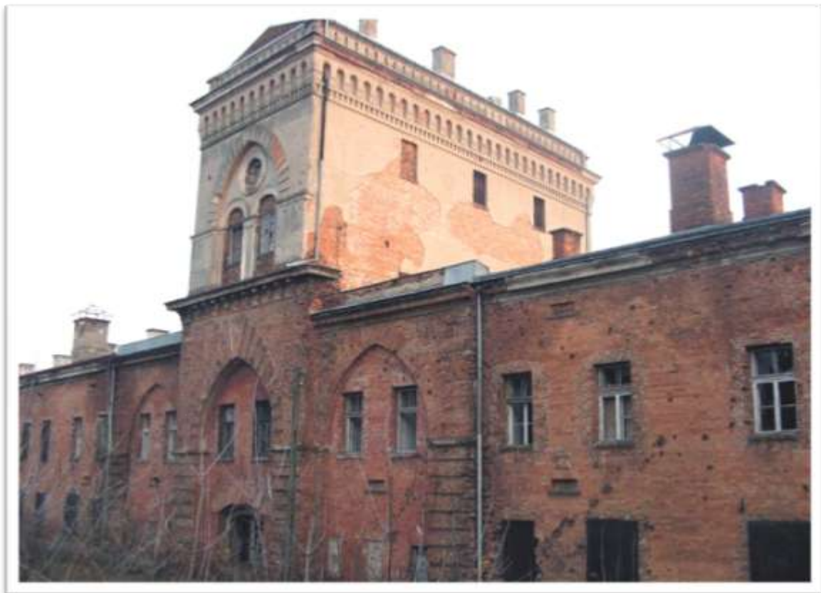
Modlin, 2010 r. Widok zewnętrzny części północno-wschodniej koszar obronnych. W wieży mieściło się ambulatorium pułku. Na lewo od wieży zakwaterowany był pułk
