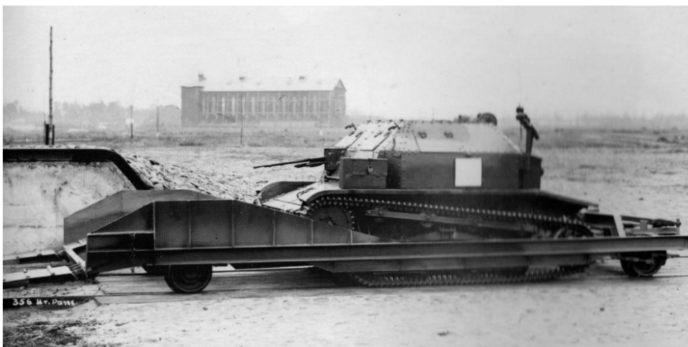
Tankietka TK-3 z radiostacją RKB na prowadnicy kolejowej (na stacji w Legionowie)
