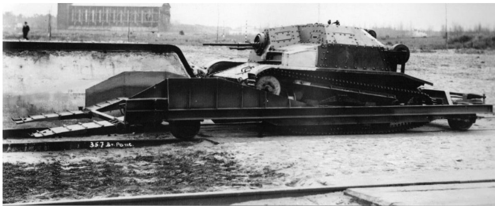
Tankietka TKS z radiostacją RKB na prowadnicy kolejowej (na stacji w Legionowie)
