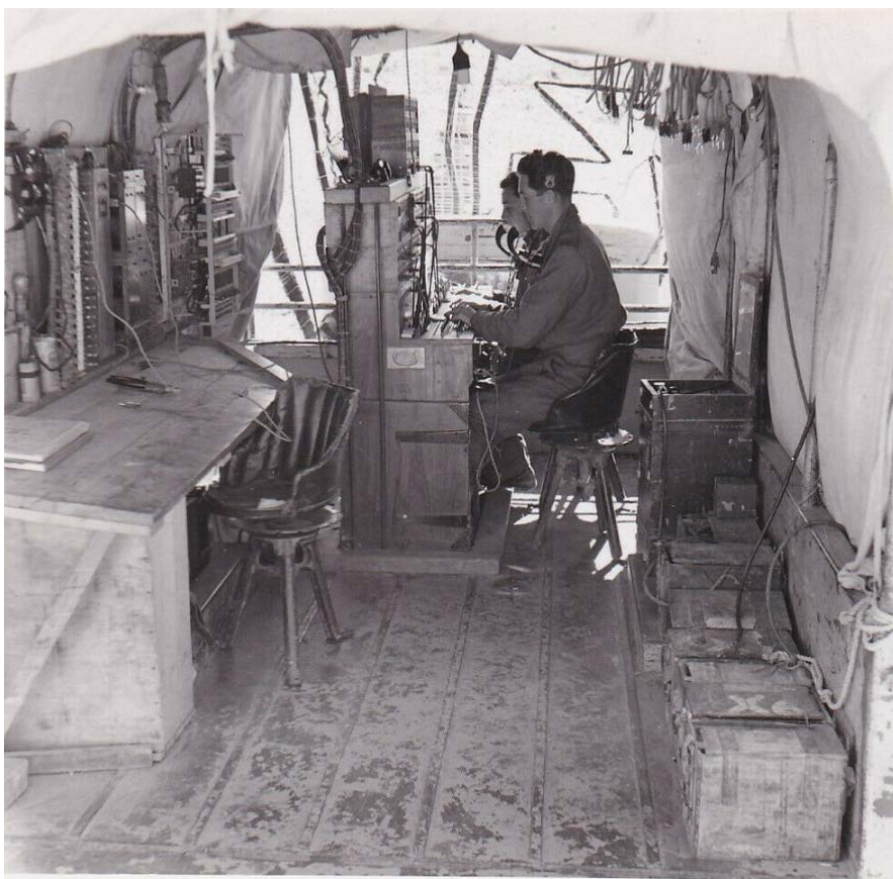
Przykład łącznicy zamontowanej na 3. tonowej ciężarówce
