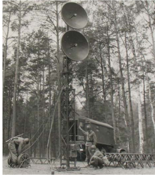
Stawianie masztu radiolinii R-404
