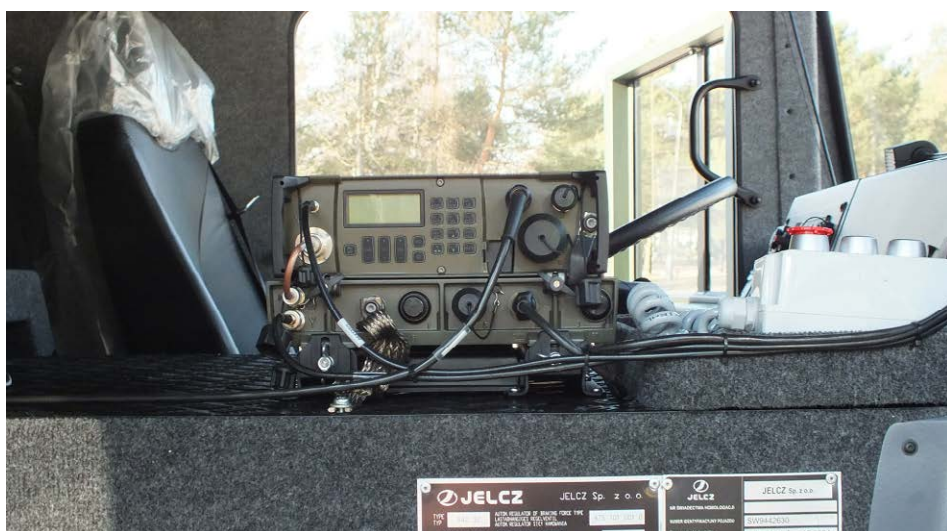
Radiostacja RRC wewnątrz kabiny kierowcy WWK-10C
