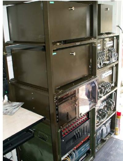
Wnętrze PWI – ściana prawa
