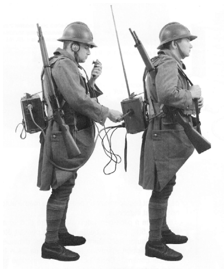
Obsługa radiostacji ER 40 w ruchu (pierwszy żołnierz niesie radiostację, drugi – skrzynkę z zasilaniem)
