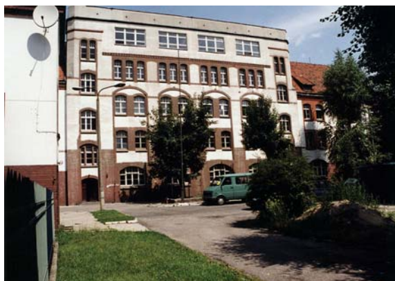
Budynek bloku szkolnego nr1 po remoncie, stan obecny.
