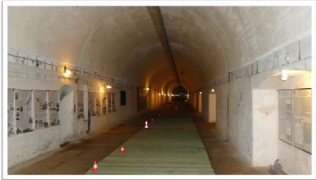
Schron to potężna konstrukcja o długości ok. 380 metrów
