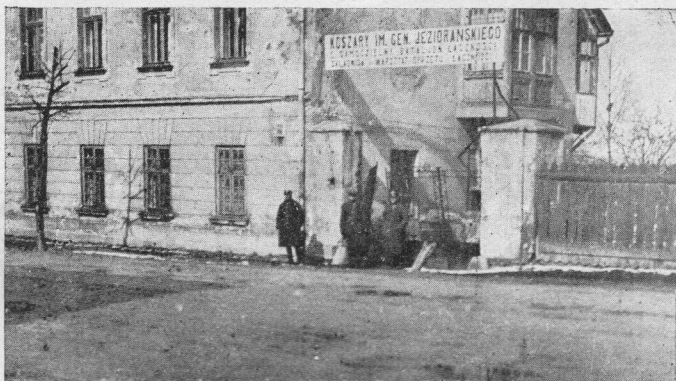
Widok zewnętrzny Warsztatów Sam. Baonu Łączności przy ul. Wielickiej.
