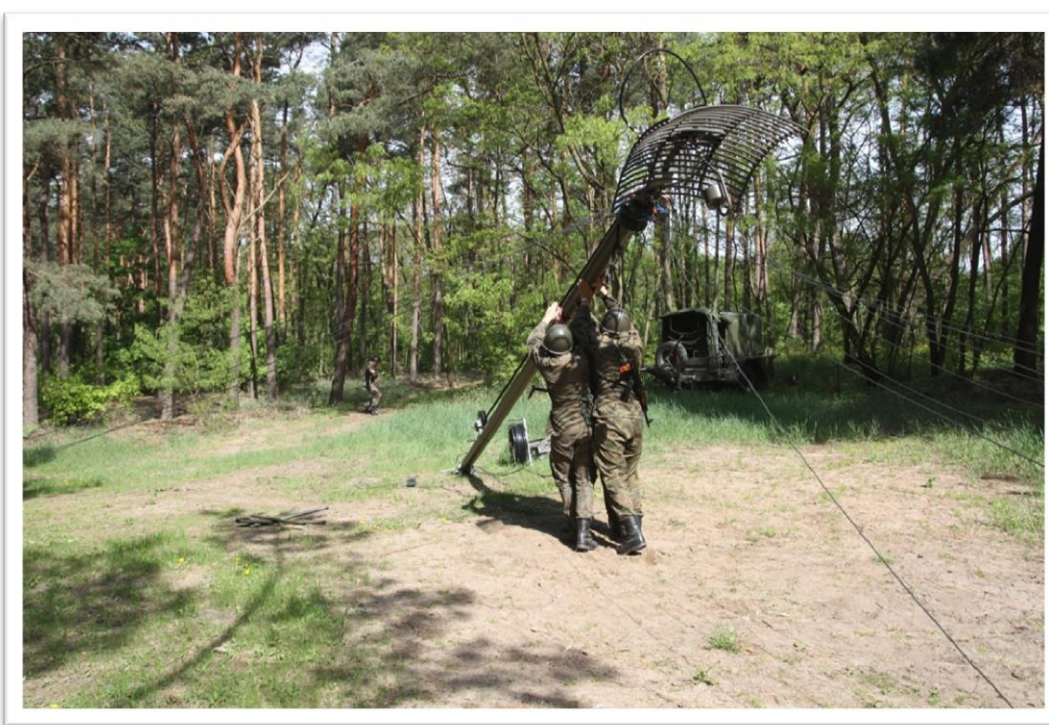
Stawianie masztu radioliniowego w aparatuwni RWŁC-10/T
