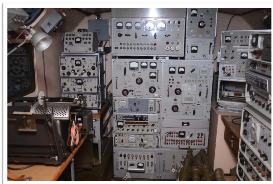
Wnętrze radiostacji R-140
