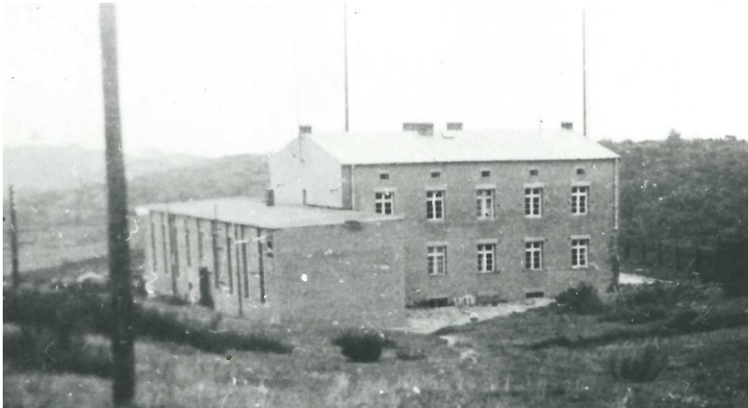
Budynek radiostacji na Oksywiu
