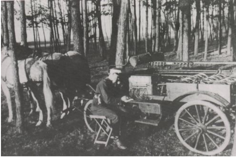
Przerobiona taczanka ckm wz.28 wykorzystana do transportu łącznicy i bębnow kablowych.
