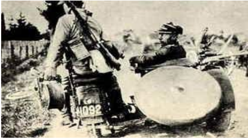
Rozwijanie linii telefonicznej z wykorzystaniem motocykla.
