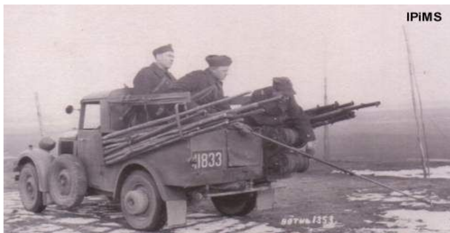
Telefoniści podczas rozwijania linii z samochodu Fiat 508/518 bez przyczepy
