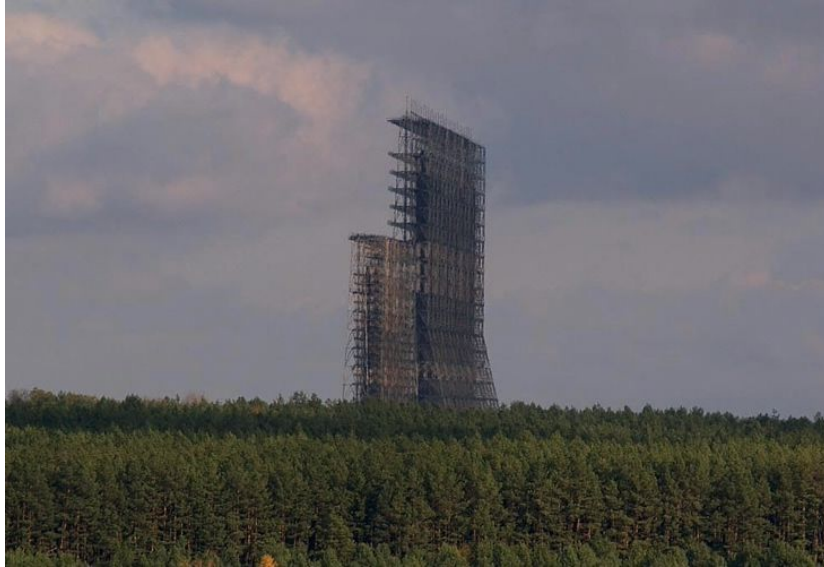
Rys. 3 Konstrukcja Dugi w Czarnobylu (Fot. s2.blomedia.pl)
