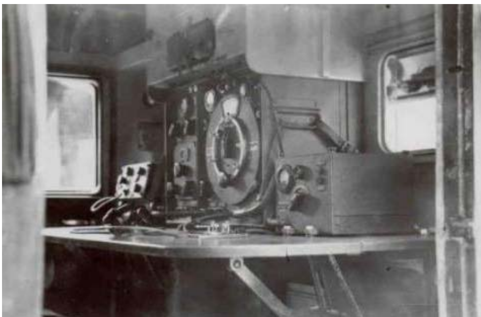
Radiostacja w wersji NIS na samochodzie Fiat 618
