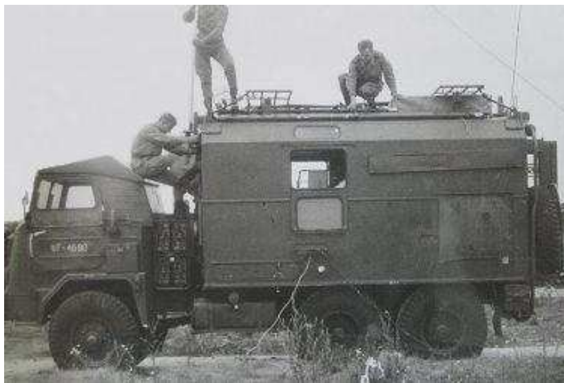
Radiostacja R-140 na samochodzie Star-660
