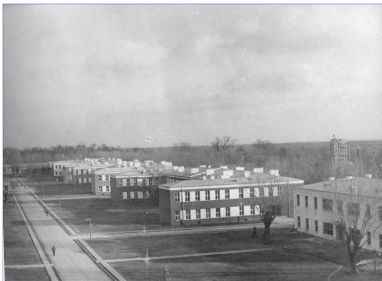
Budynki przeznaczone na zakwaterowanie żołnierzy, którym dobudowano piętro
