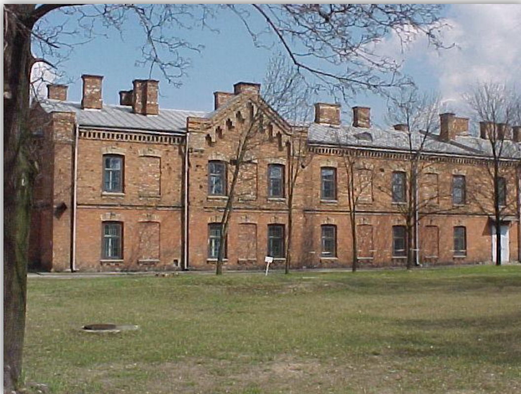
Zdj. 14. Budynek przeznaczony na zakwaterowanie żołnierzy
