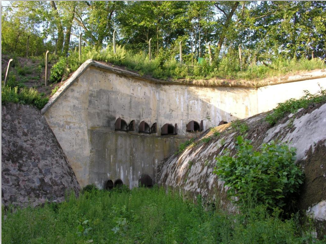
Zdj. 1. Kaponiera grodzowo-przeciwskarpowa
