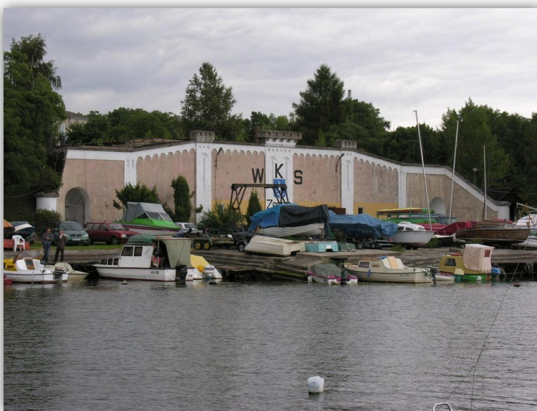
Zdj. 8. Prochownia zachodnia
