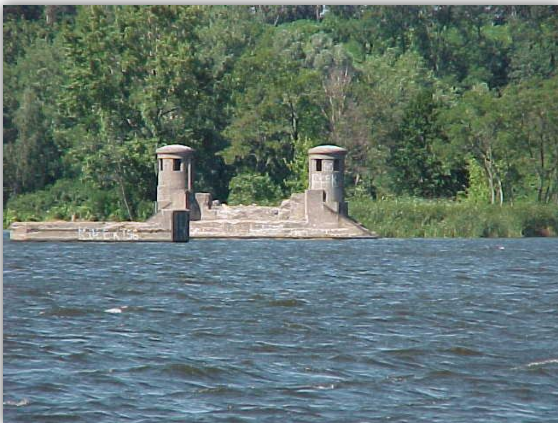
Zdj. 16. Pozostałości mostu z 1894 r.
