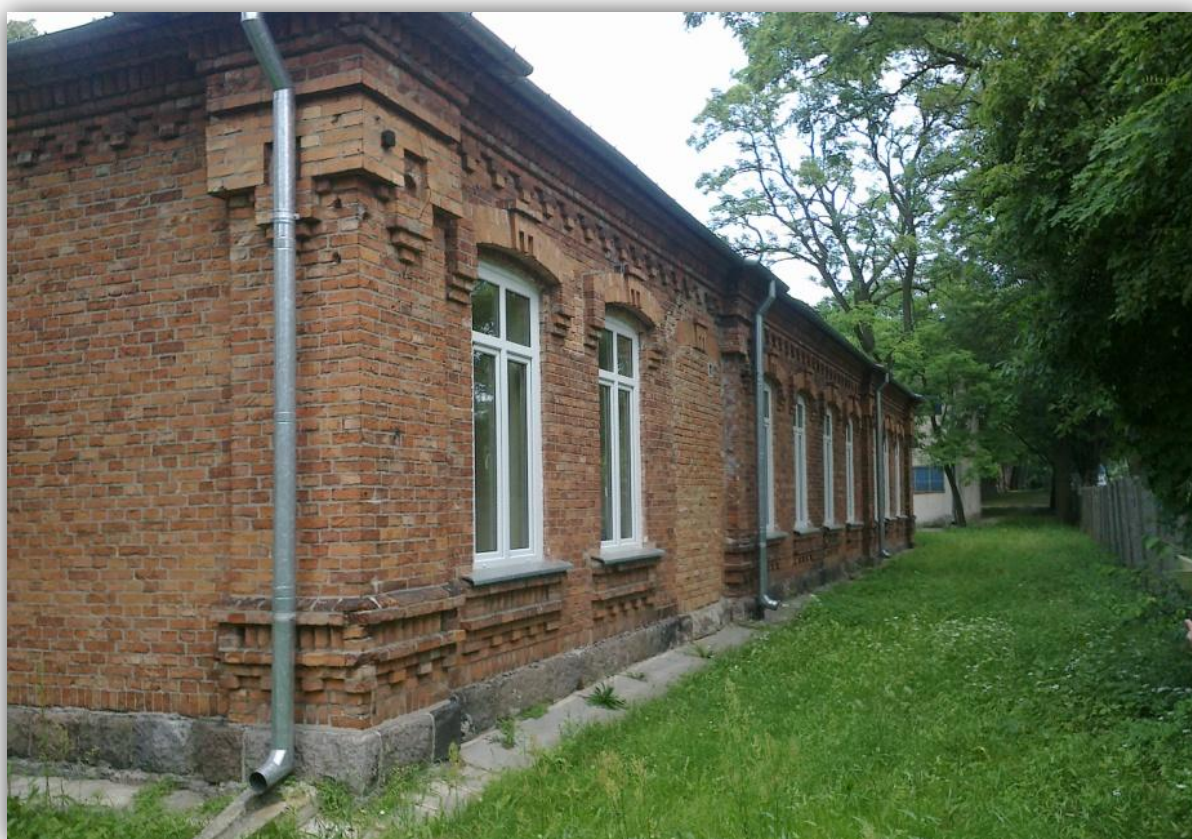
Zdj. 11. Budynek przeznaczony na zakwaterowanie oficerów
