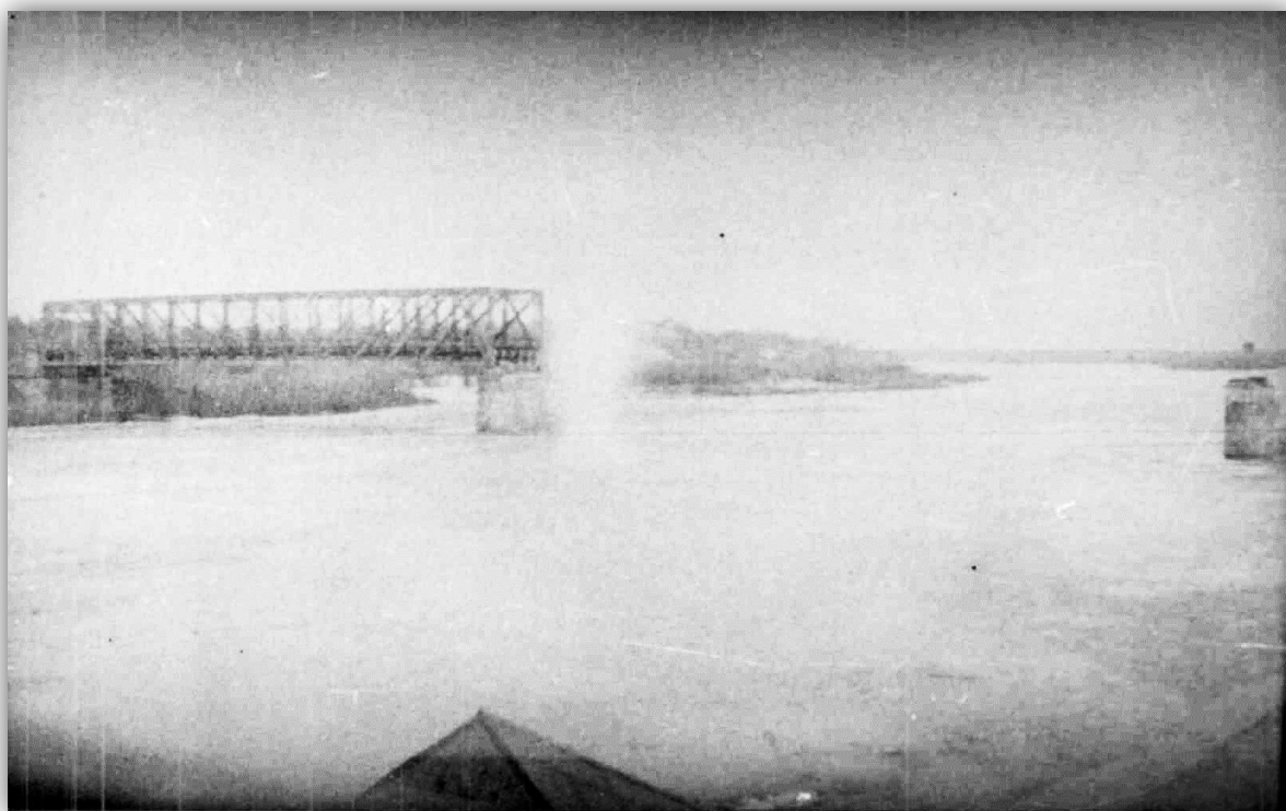
Zdj. 17. Most z 1897 r. po wysadzeniu w 1915 r.
