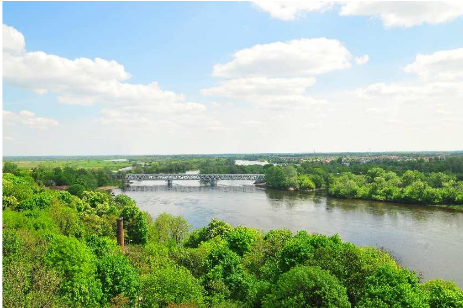
Widok z Wieży Białej na most na Narwi
