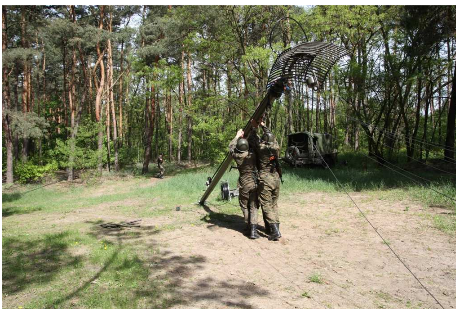
Stawianie maszty radioliniowego w aparatowni RWŁC-10/T
